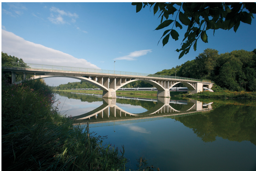
Райзенбург: Железобетонен мост (Германия / Бавария), построен през 1920 г. на мястото на гървен мост.
